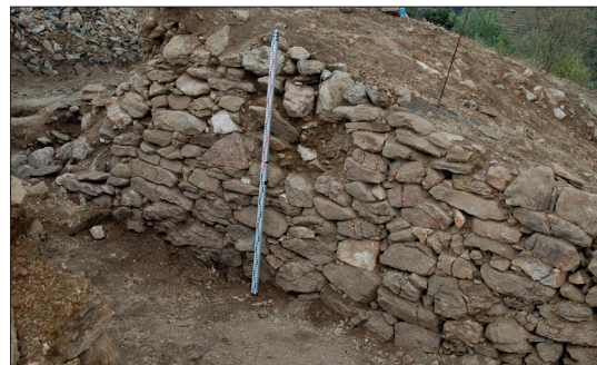
Fig. 14-15 – Paramentos do corredor (Est. II e III).
