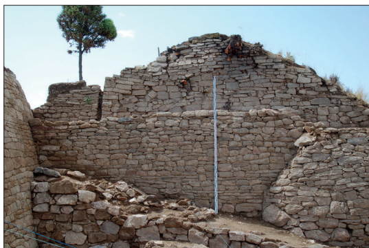
Fig. 18 – Torre, sobre o soco do torreão. No canto inferior direito vê-se o muro de contrafortagem do torreão (Est. XII); No canto superior esquerdo vê-se o muro que condenou o vão de acesso à torre (Est. XXI).
