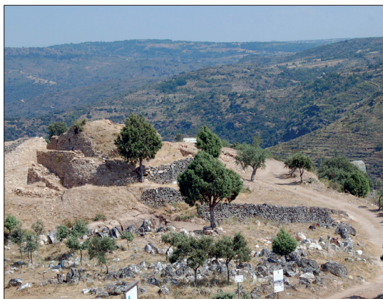
Fig. 6 - Vista parcial do Castelo dos Mouros, com o campo de Pedras Fincadas em 1º plano.
