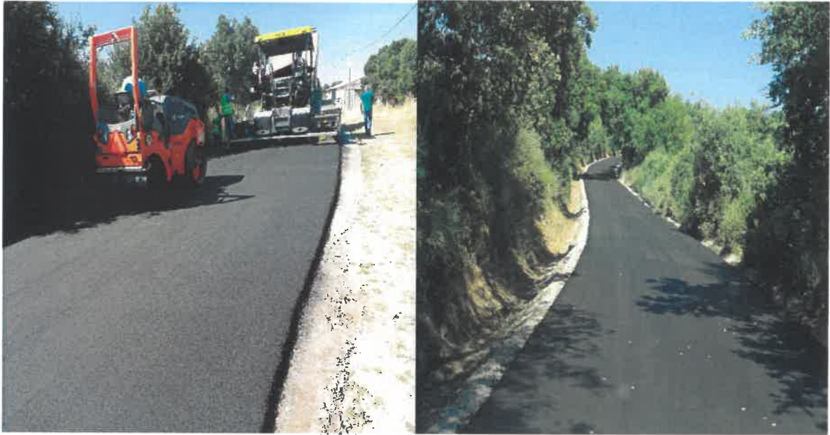
Figura 8 - E.M. 593 entre Remondes e a E.N.216
