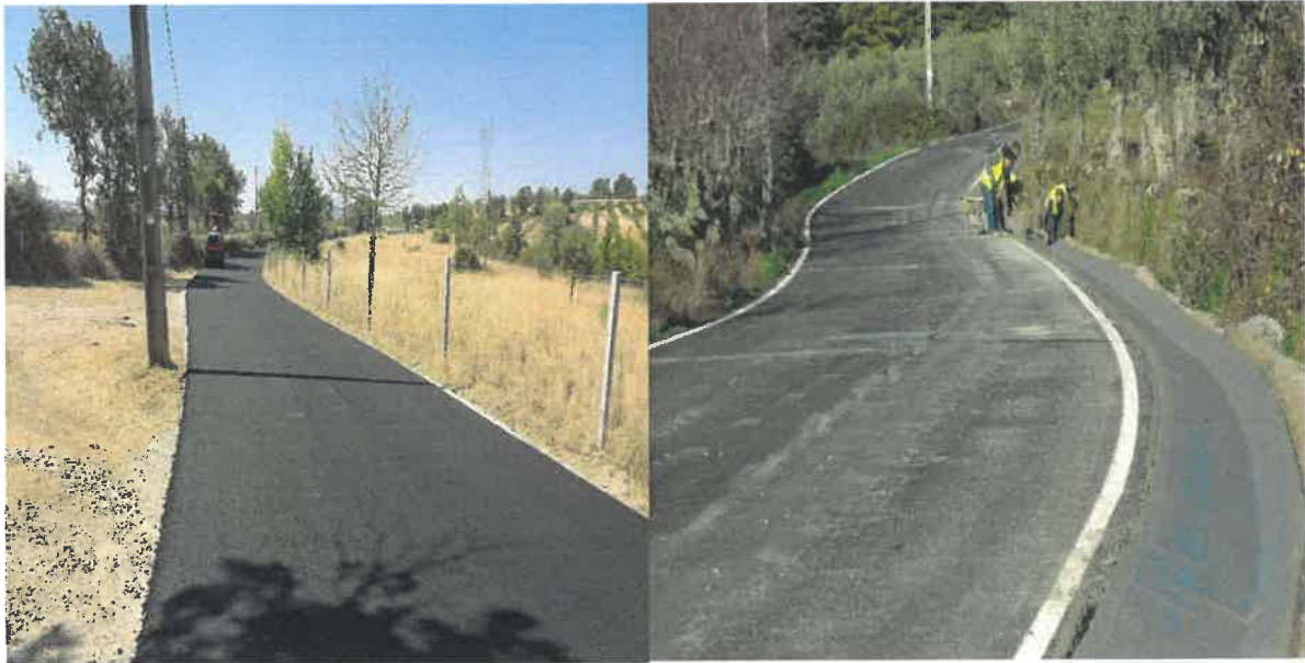
Figura 9 – Pavimentação do Caminho do Rodelão e caminho rural entre Urrós e Bemposta
