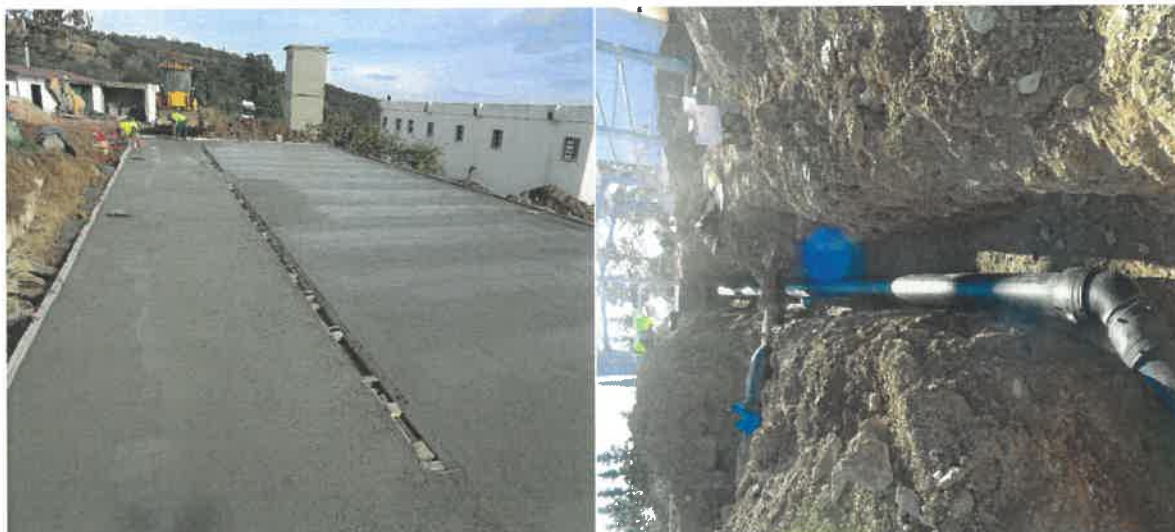
Figura 4 – Remodelação da ETA de Bastelos
