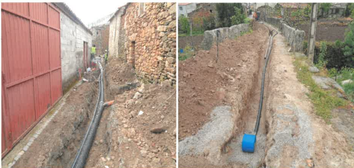
Remodelação da rede de água e saneamento de Vilarinho dos Galegos
