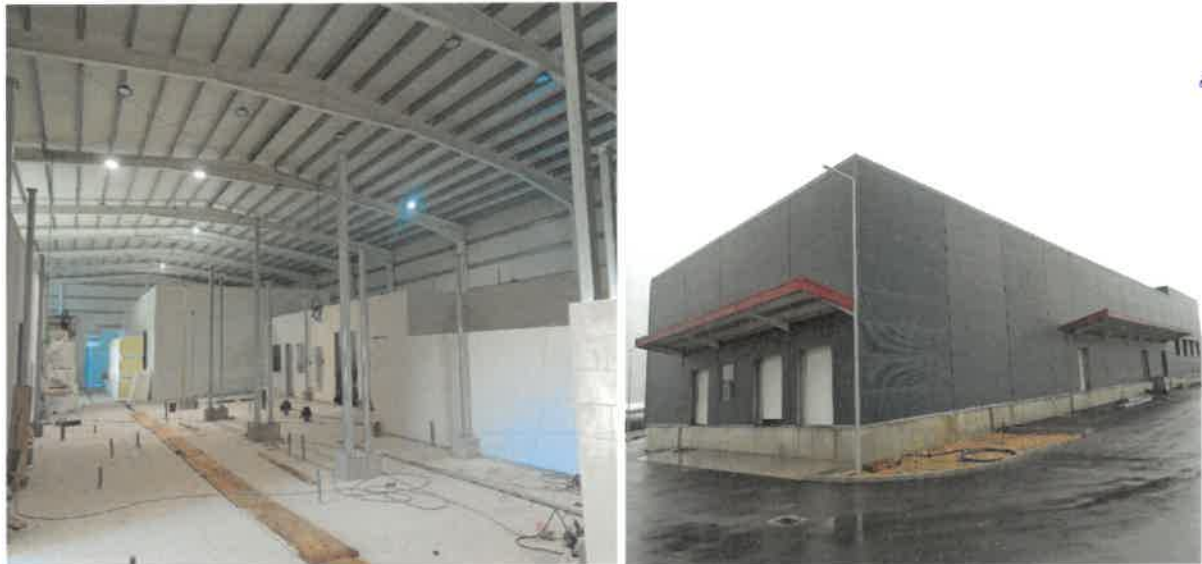
Construção do Matadouro Municipal
