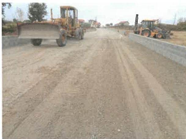
Arruamentos no Concelho – Bemposta
