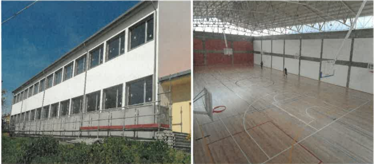
Reabilitação funcional do Edifício da Escola Secundária de Mogadouro e Pavilhão Gimnodesportivo
