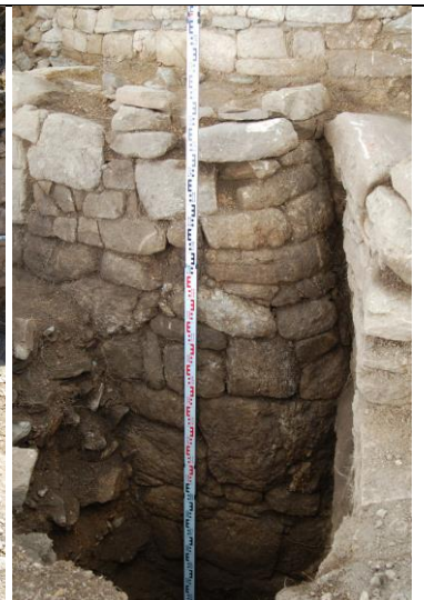
Fig.12- Muro de contrafortagem
