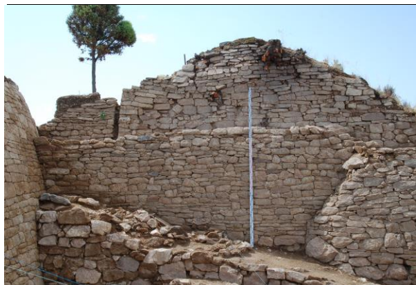
Fig. 15- Muros de contenção e torre angular
